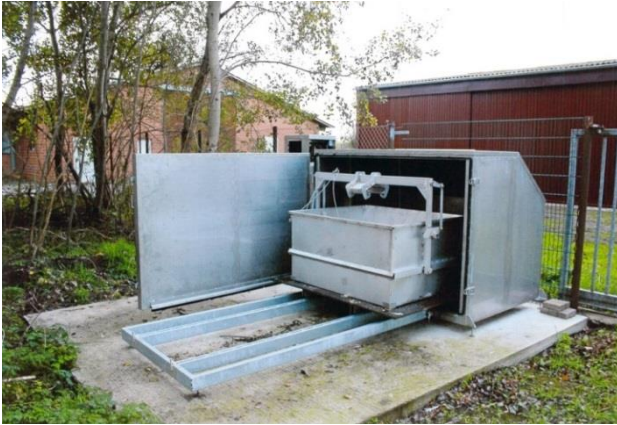
Abbildung 28: Oberirdische Kadaverlagerung in Kühlung mit Schienensystem zum leichteren Handhaben. Befüllen des Containers von der Hofseite ©LMG Nord
