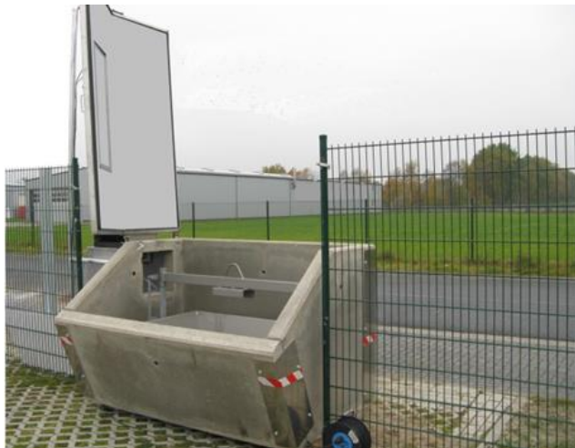
Abbildung 30: Gekühlte oberirdische Kadaverlagerung; Deckel mit Seilwinde zu öffnen; Abholung ohne Befahren des Betriebes ©LMG Nord
