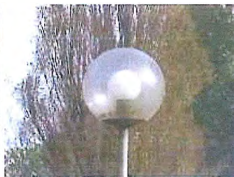
Bild 2 – Detail vorhandener Leuchtenkopf
