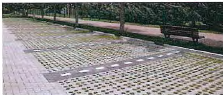
Beispiel einer Rasengittersteinparkfläche
