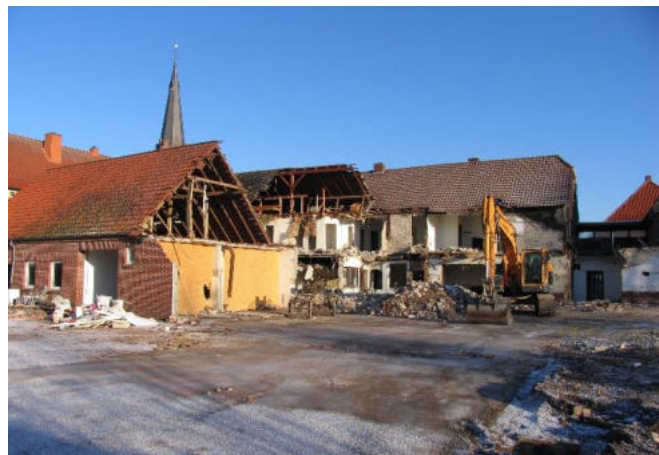
Abbildung 26: Abbruch in Molbergen.
