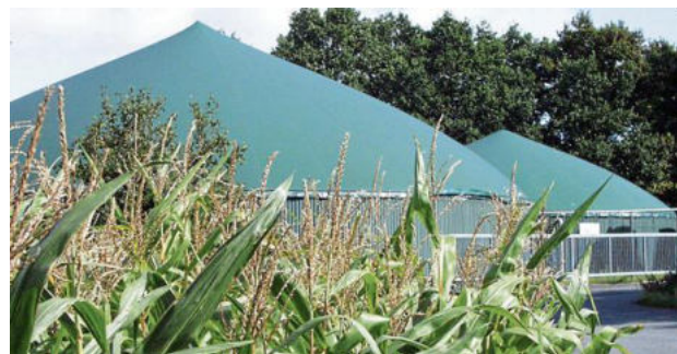
Abbildung 29: Biogasanlage LK Cloppenburg.
